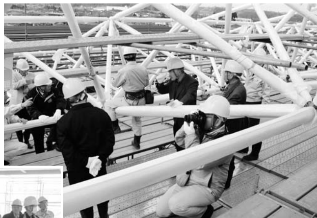
屋根工事現場を視察
