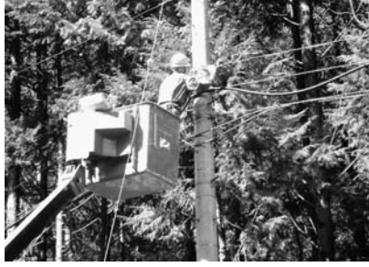
工事が進む光ファイバー敷設
