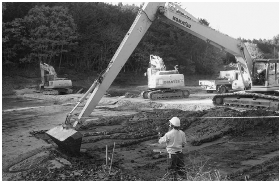
土壌掘削状況
