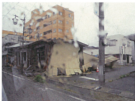
浪江町市街地で倒壊したまま放置されていた家屋
