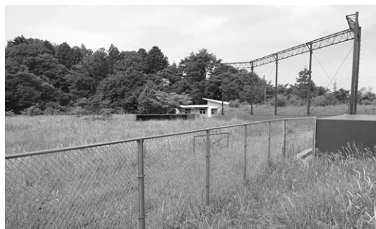
復旧工事前の高瀬球場
