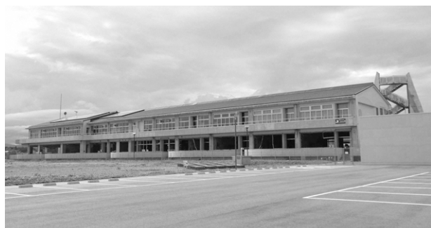
震災遺構浪江町立請戸小学校
