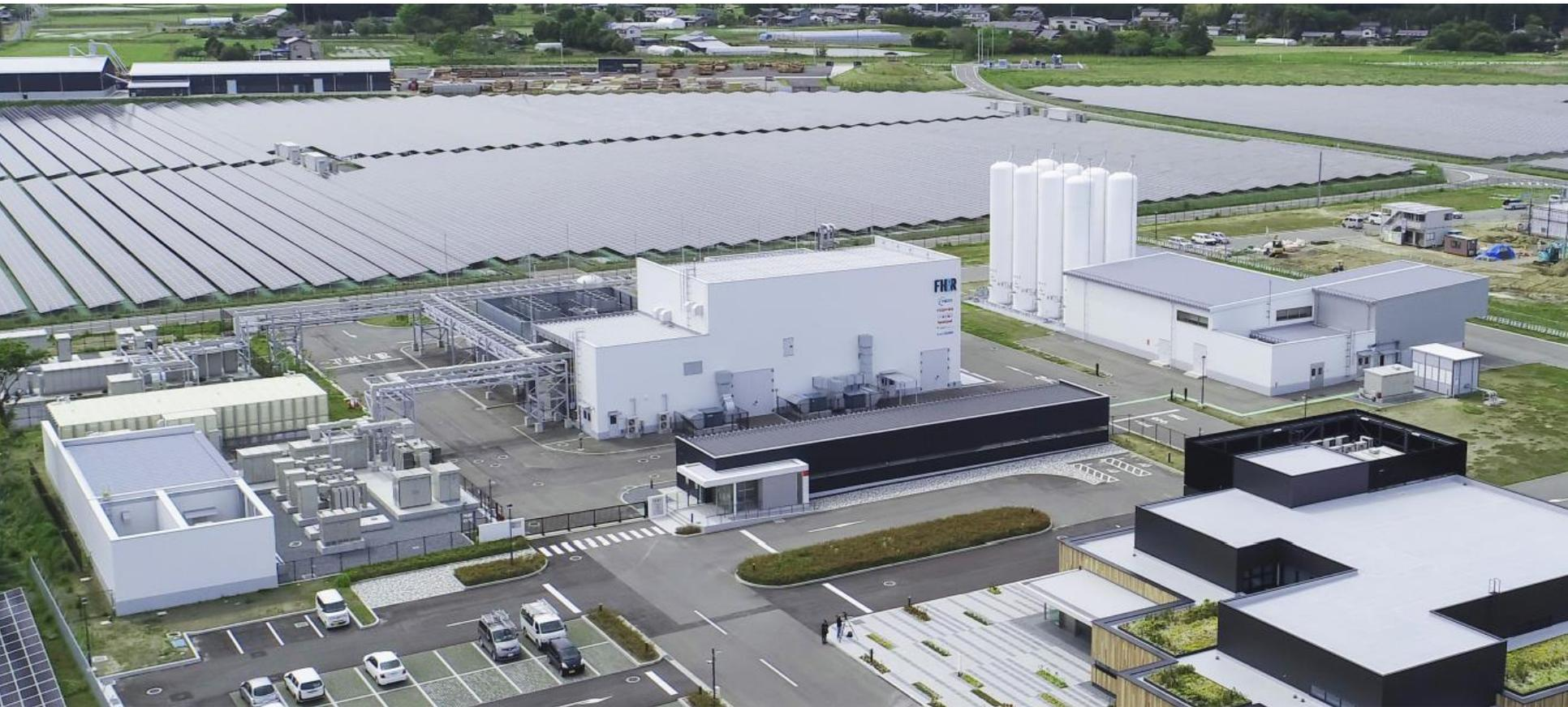
棚塩産業団地の福島水素エネルギー研究フィールドでは、周りにある太陽光パネルの電気で浪江町の水を電気分解して水素を作っています。
