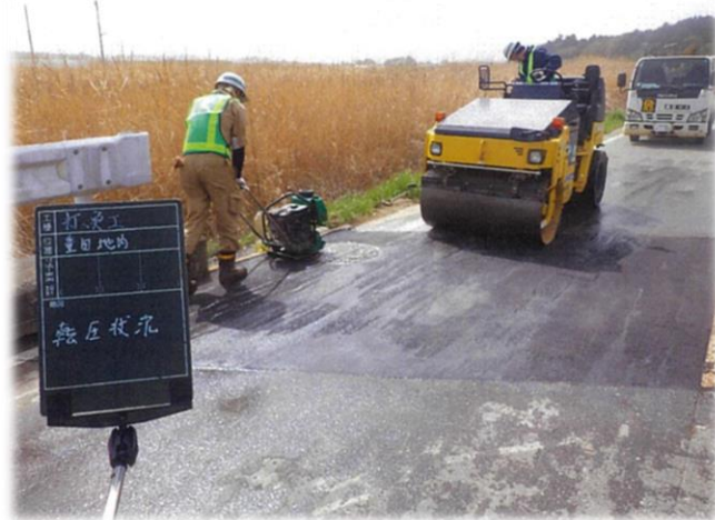
道路修繕状況
