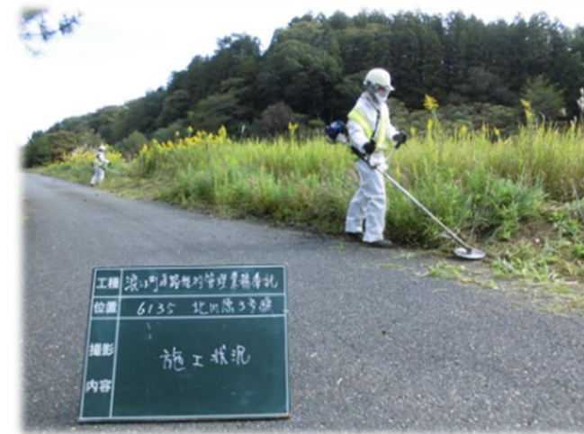
道路草刈り状況
