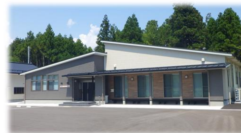
大堀防災コミュニティセンター
