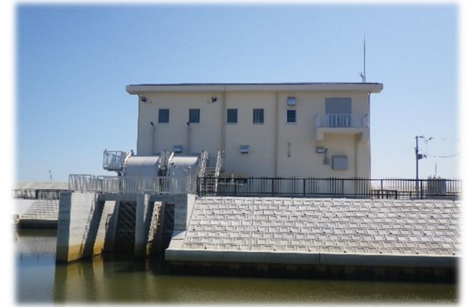
復旧した棚塩排水機場
