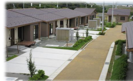
請戸住宅団地
