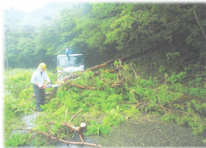
支障木伐採状況
