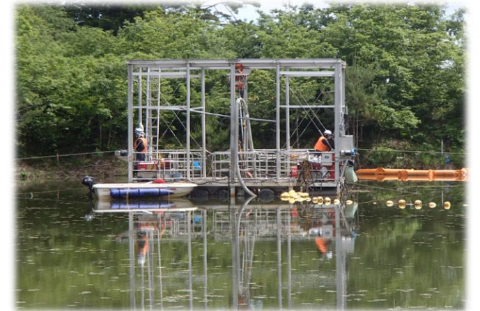
ため池の底質除去工事（ポンプ浚渫）
