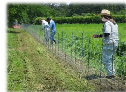
有害鳥獣侵入防護柵の設置
