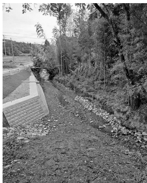
堀知木川災害復旧状況
