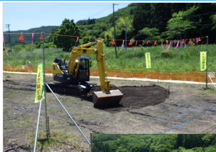
●表土の削り取り
