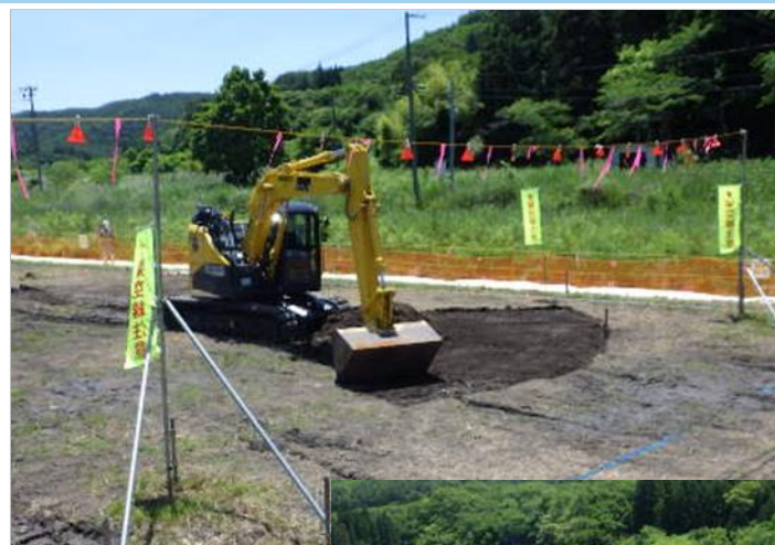
●表土の削り取り
