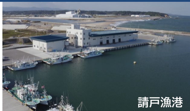
福島高度集成材製造センター
