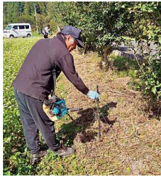
②支柱に絡んだ草の除去
