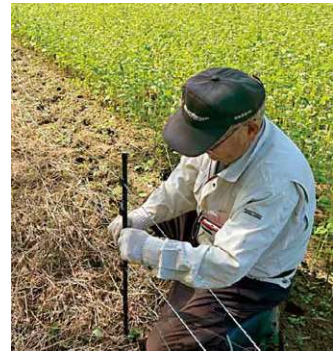
③たるんだ電線の張り直し
