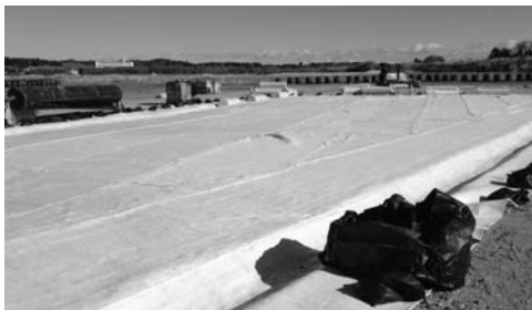
現在、造成中の酒田行政区の仮置き場
