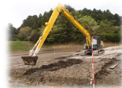
ため池の底質除去工事 (バックホウ掘削)
