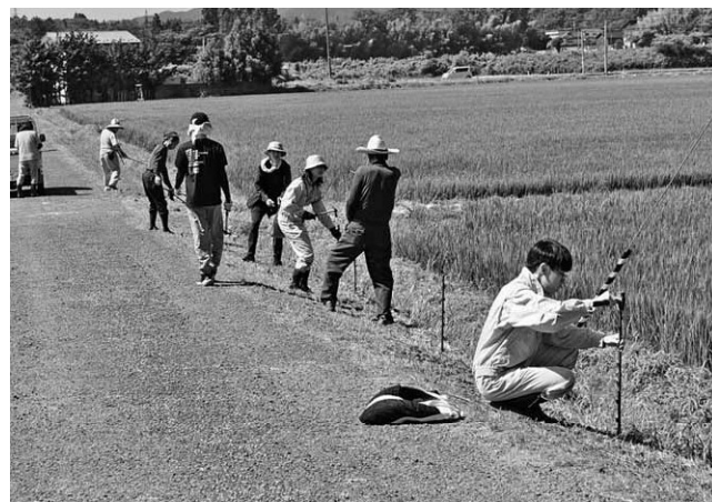
③ 電気柵設置の様子
