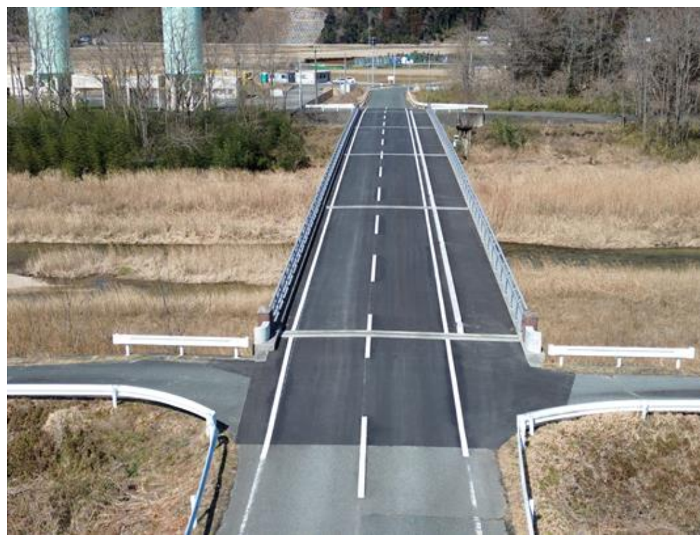
谷津田橋補修
