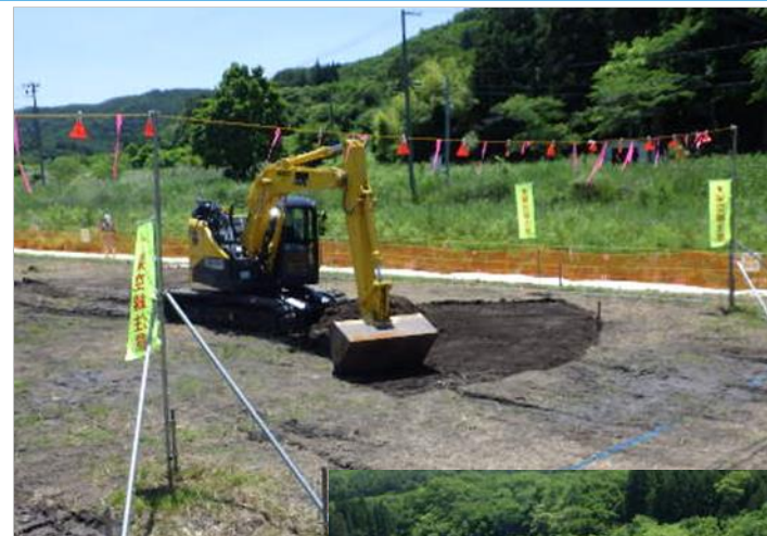
●表土の削り取り
