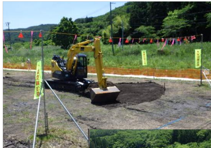
●表土の削り取り
