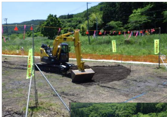
●表土の削り取り
