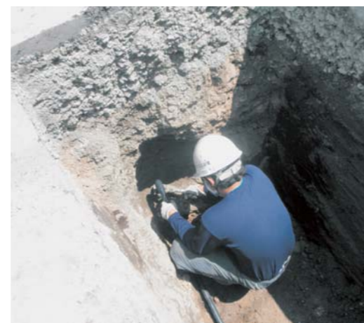
上水道の漏水修繕工事の様子
