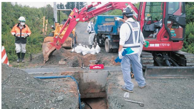
常磐自動車道の浪江IC開通に伴い行われた、浪江IC事務所への給水管接続工事
