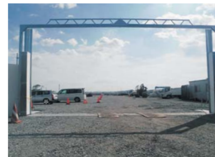
整備が一部完了した棚塩第二仮置場
