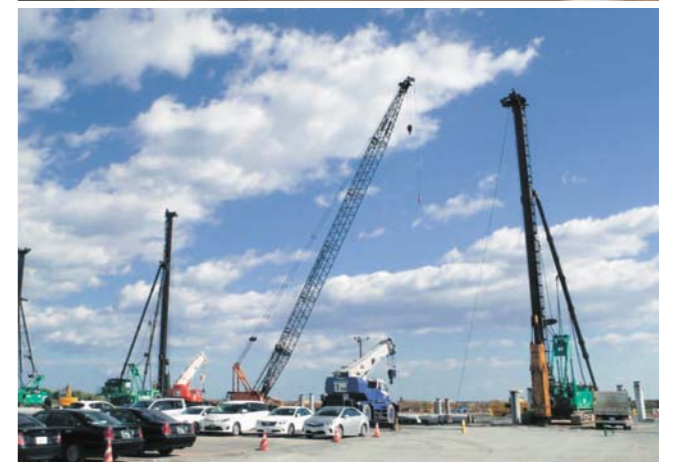
杭打ち作業の現場
