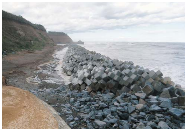
完成した棚塩地区北部の消波ブロック
