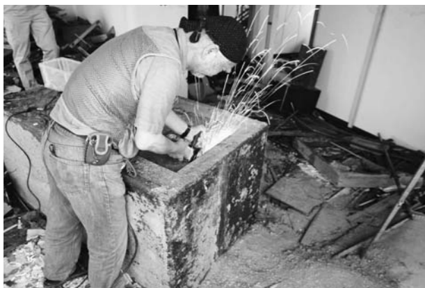
金庫の解体の様子
