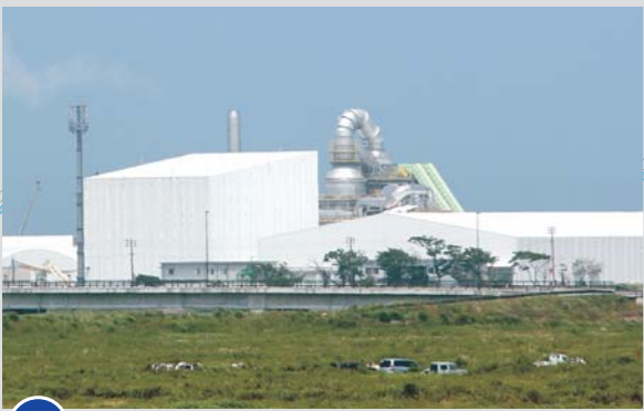
3 稼働開始した仮設焼却施設
