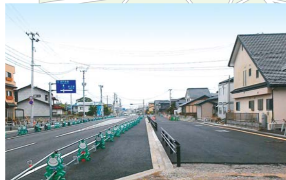
拡幅された国道114号
