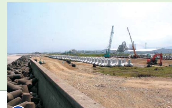
7 海岸の災害復旧工事
