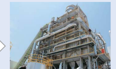
可燃物を燃やして減容化する仮設焼却施設 （平成27年7月稼働開始、300トン/日）
