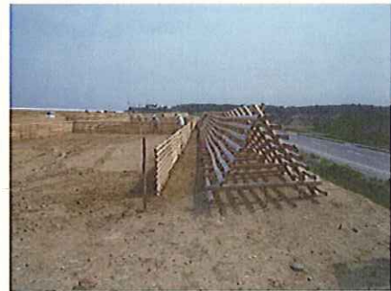
防風柵（移動式）と静砂垣の設置状況
