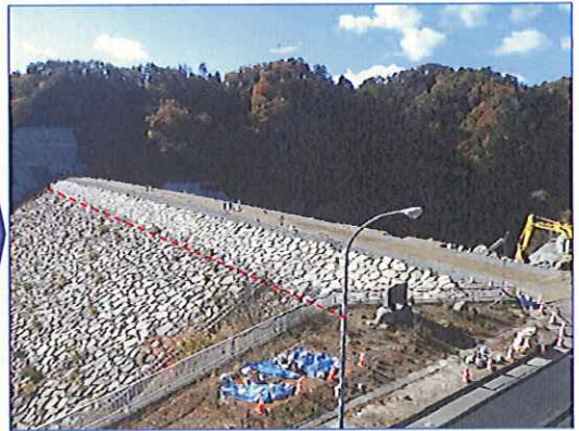
復旧(掘削・再盛立)した堤体 ※復旧範囲: EL167.2~174.0m、現在EL174.0m (写真の --- から上を施工)
