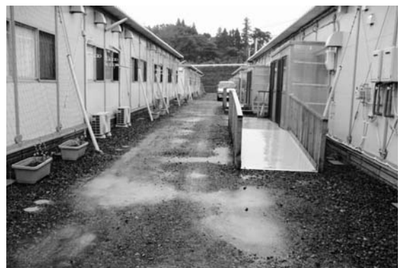
水たまりができる敷地（仮設住宅）
