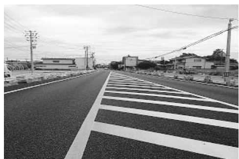
拡幅予定の114号線第2工区
