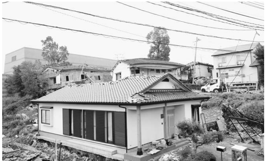
熊本県益城町の被災状況
