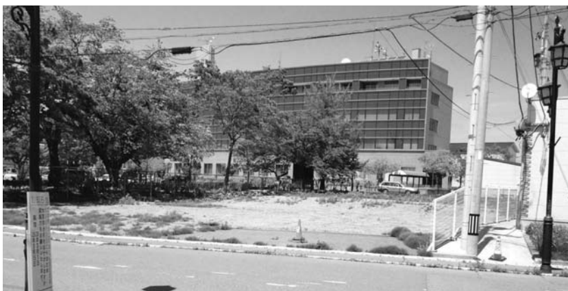
浪江本庁舎東側の浪江仮設商業施設建設予定地
