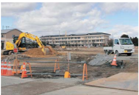
災害公営住宅
