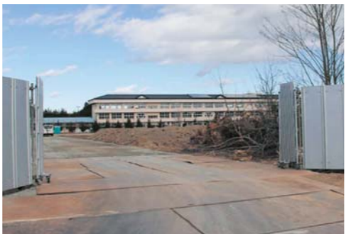
「浪江東中学校改修・浪江認定こども園新築工事」現場
