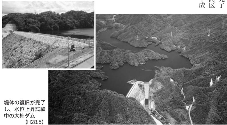
堤体の復旧が完了し、水位上昇試験中の大柿ダム(H28.5)
