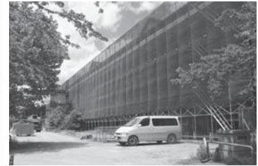
現在の工事状況
