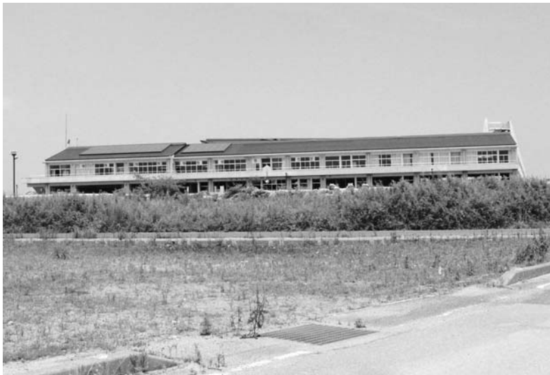
震災遺構として整備が待たれる請戸小学校
