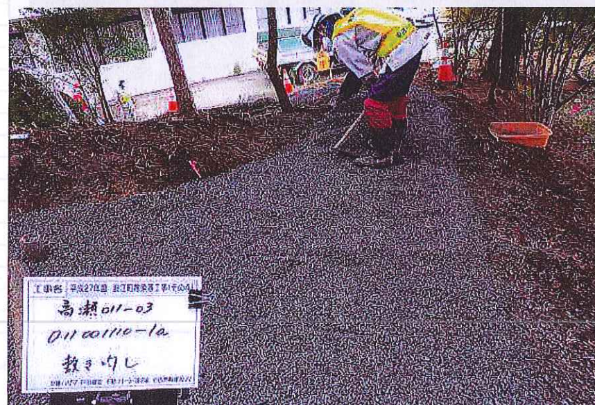
平成27年度浪江町除染等工事(その4)
