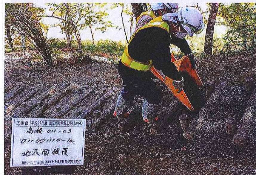
平成27年度浪江町除染等工事(その4)
