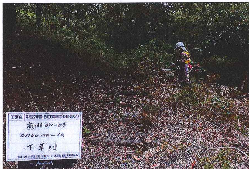
平成27年度浪江町除染等工事(その4)
