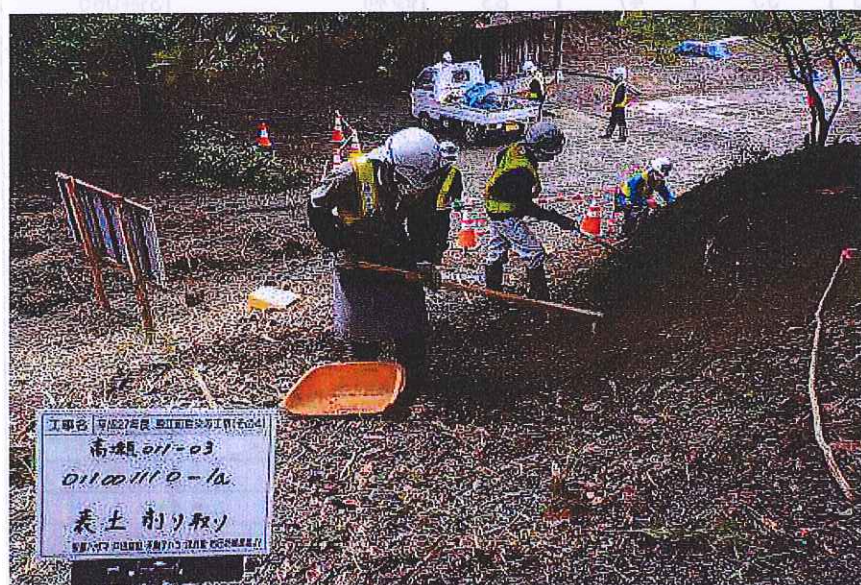
平成27年度浪江町除染等工事(その4)
