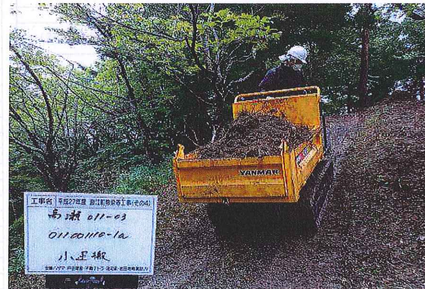
平成27年度浪江町除染等工事(その4)
