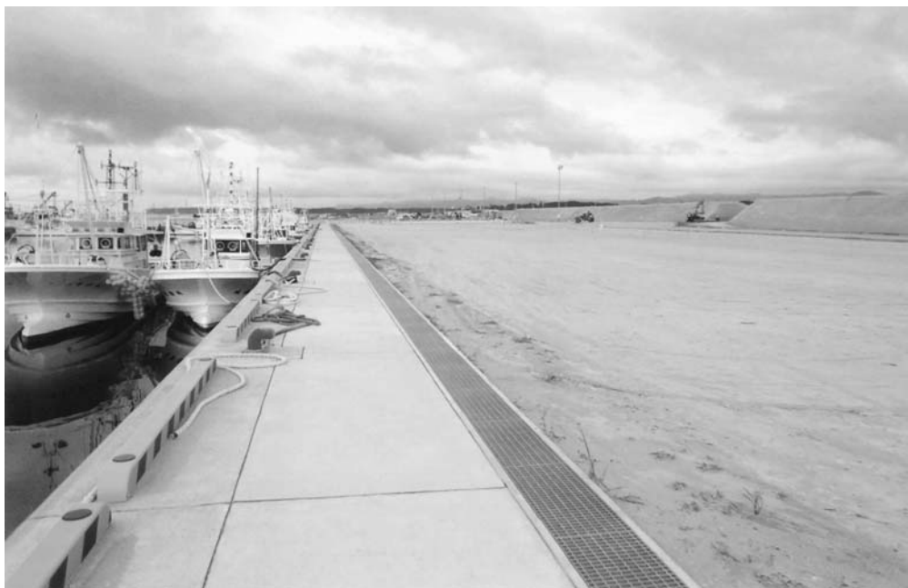
整備が進む請戸漁港
