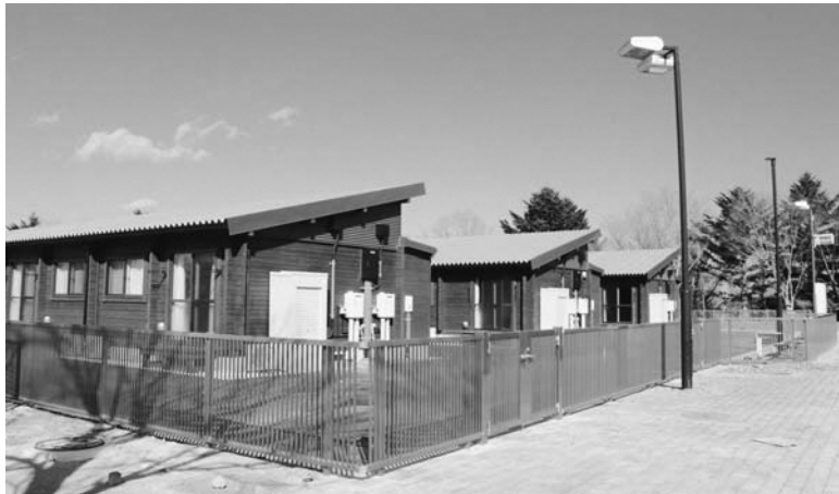
福島いこいの村なみえ（ログハウス）（2月4日撮影） 本館の大浴場、休憩室等の改修に加え、ログハウスを整備中
