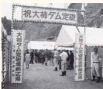
昭和55年、大柿ダム定礎式
