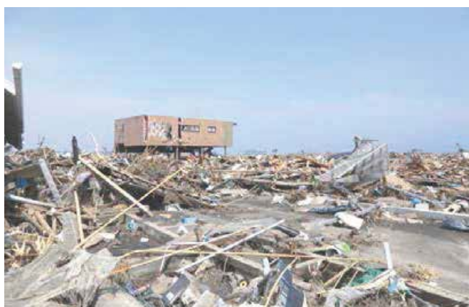
両竹地区の津波被害の様子
