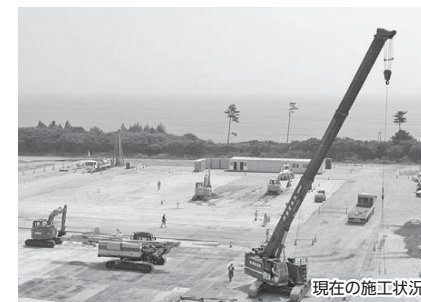
現在の施工状況
