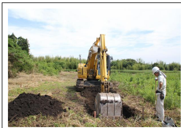
確認調査の様子 重機を使つての作業
