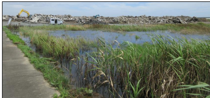
写真3 台風通過後の移転元地（令和3年8月撮影）
