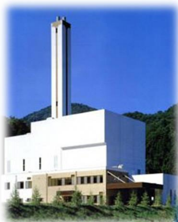
北部衛生センター外観及び位置図 (浪江町室原字於喜津 4-1) 国道 114 号沿い
