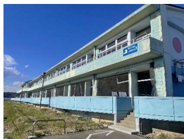
震災遺構浪江町立請戸小学校
