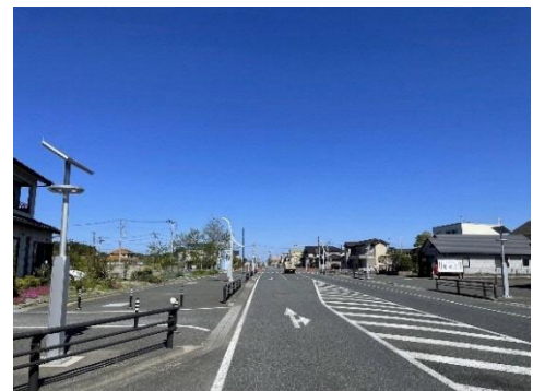
電線地中化による景観整備が行われている国道 114 号
