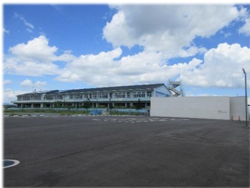
震災遺構浪江町立請戸小学校
