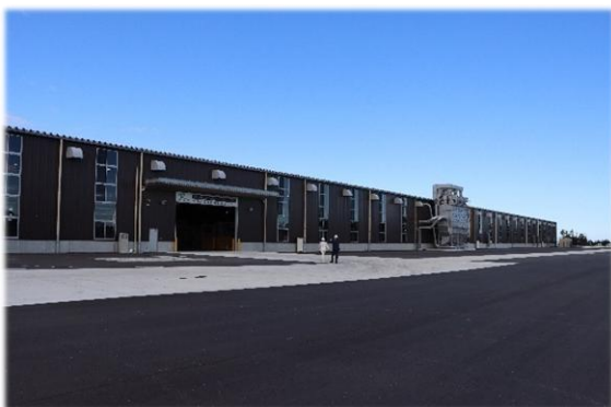
福島高度集成材製造センター（F L A M）
