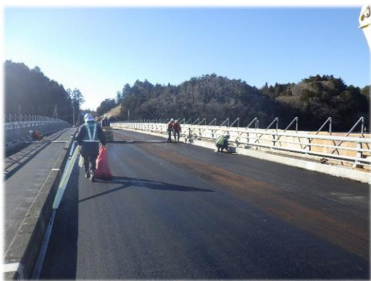
道路管理・補修
