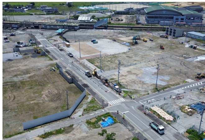
浪江駅周辺ドローン撮影 (令和8年6月29日撮影)
