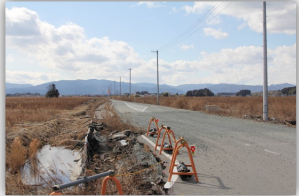
棚塩地区 電柱復旧状況
