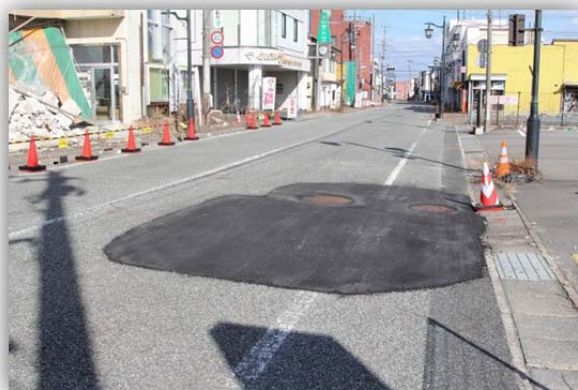
道路仮復旧状況
