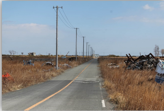
請戸地区 電柱復旧状況
