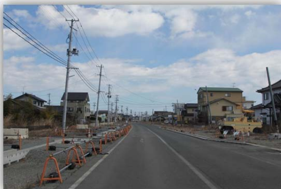
国道114号 第1工区
