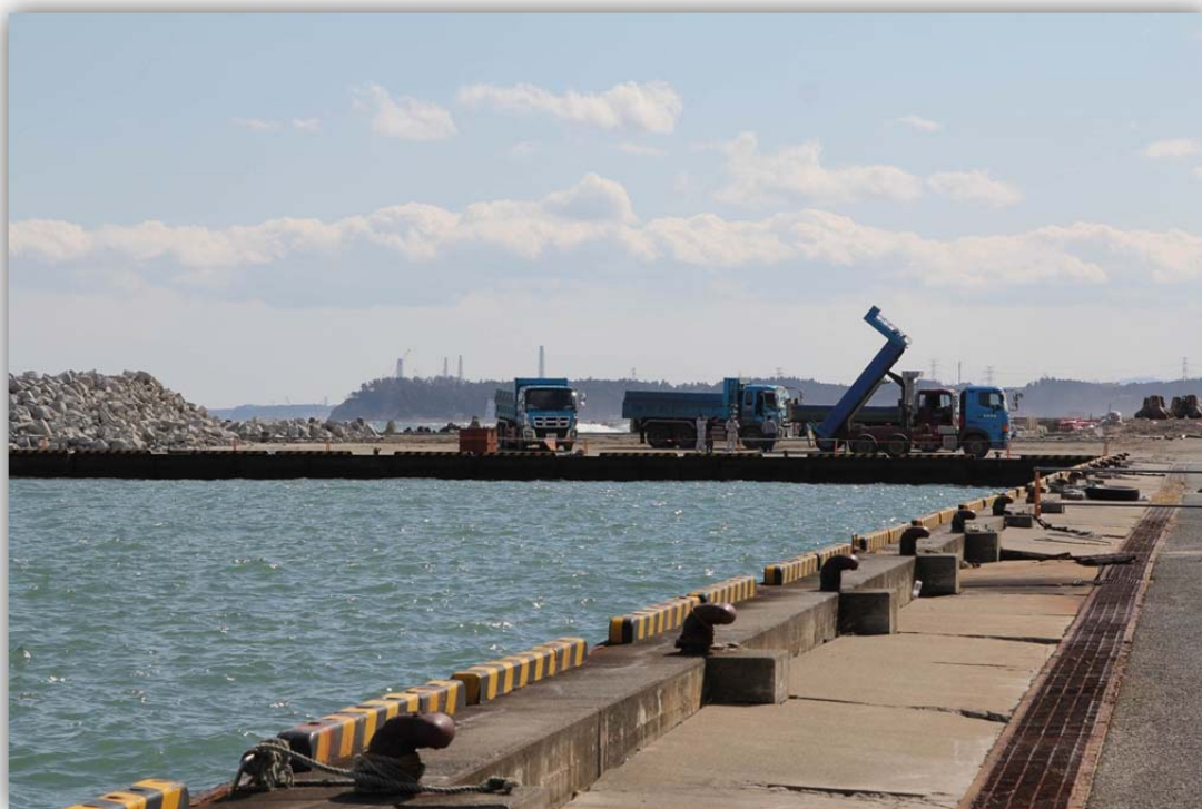
請戸漁港 復旧工事
