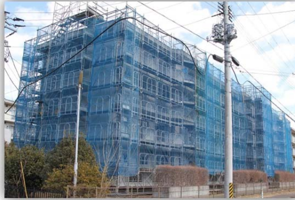
除染作業中の酒田町営住宅
