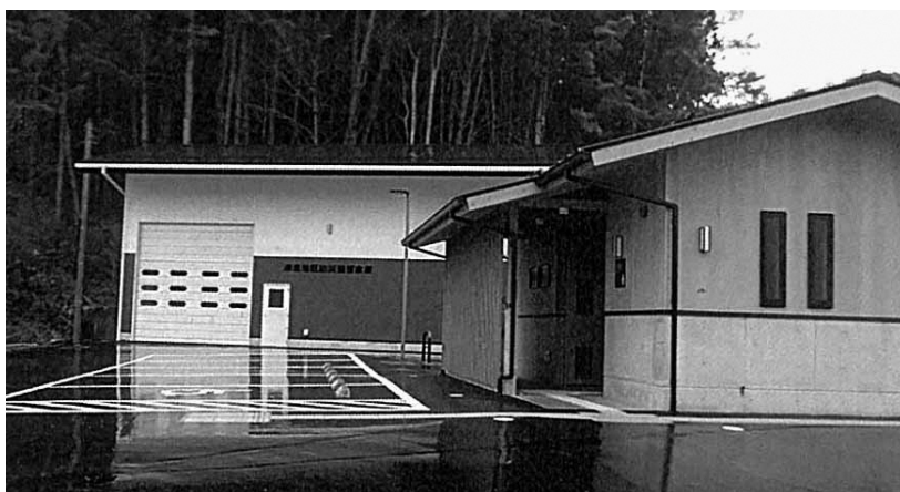
備蓄倉庫と公衆トイレ
