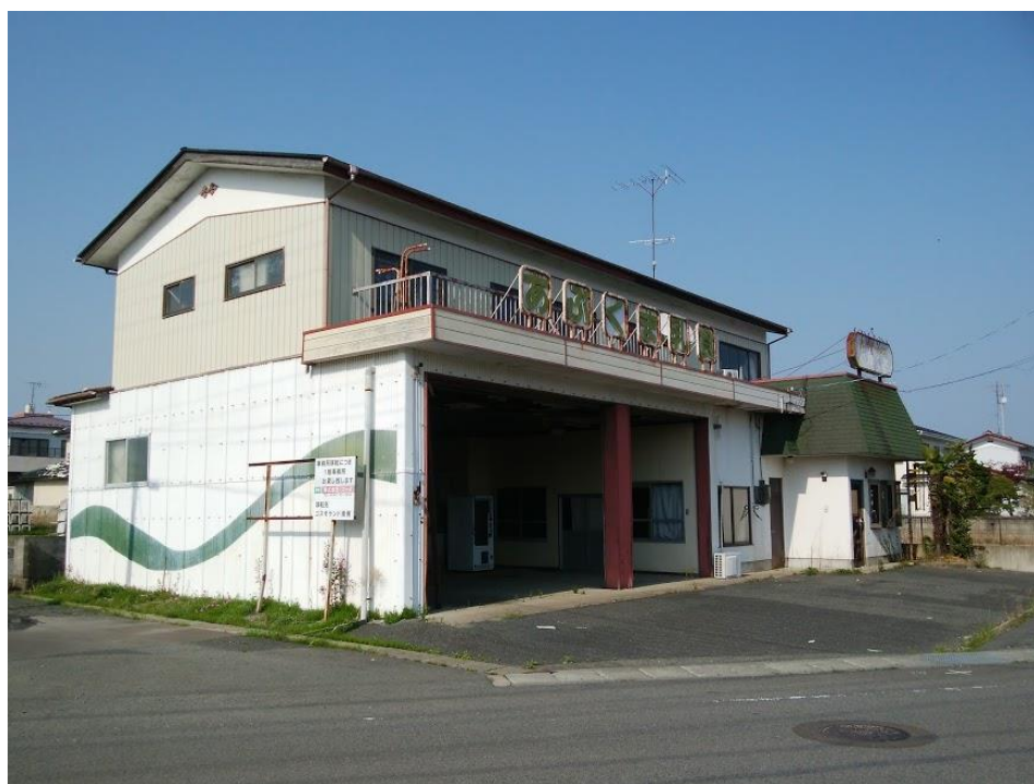
(12)外観 (建物解体予定)
